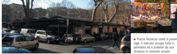
Piazza Testaccio come si presenta oggi. Il mercato occupa tutto il perimetro ed è protetto da una struttura in cemento armato
