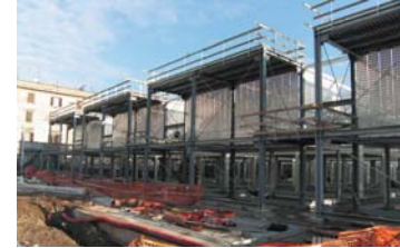
Il nuovo mercato coperto è in costruzione (in project financing affidato alla Ptm Srl) su un'area libera, un tempo campo di calcio. A poca distanza c'è invece l'area dove nel 1929 fu costruito il primo stadio della Roma (che fu demolito nel 1940 per motivi di sicurezza)
